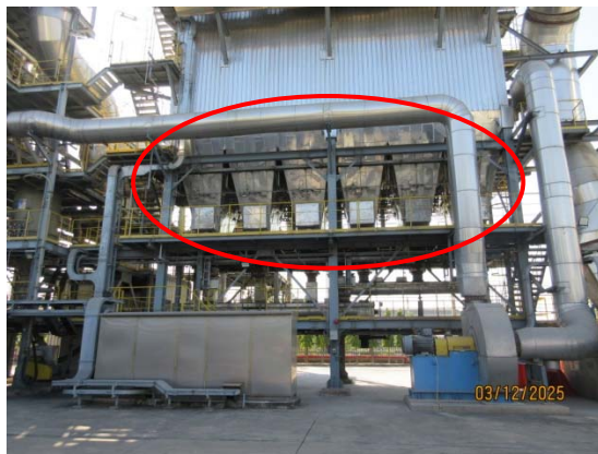
รูปที่ 9 ระบบดักฝุ่นแบบถุงกรอง (Bag Filter)
