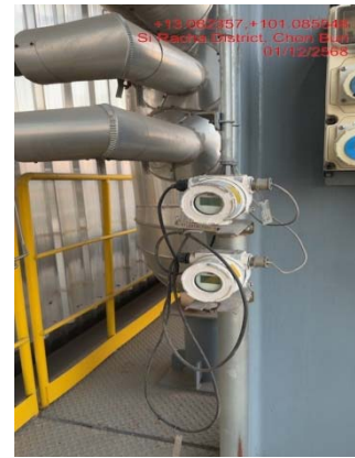
รูปที่ 78 อุปกรณ์ตรวจวัดอุณหภูมิของหม้อไอน้ำ
