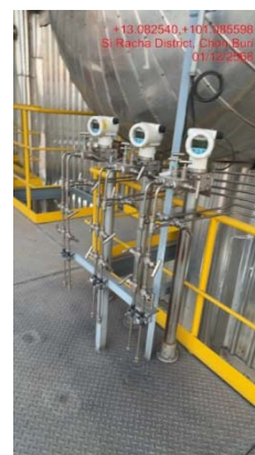
รูปที่ 76 อุปกรณ์ตรวจวัดความดันของหม้อไอน้ำ
