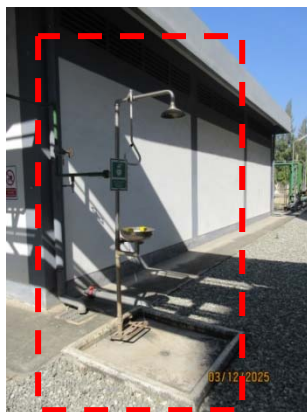
รูปที่ 75 ฝักบัวฉุกเฉินและอ่างล้างตา บริเวณพื้นที่เก็บสารเคมี
