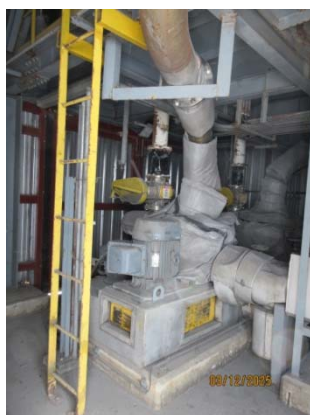
รูปที่ 7 ระบบควบคุม SO 2 และ HCl แบบ Dry-absorption System
