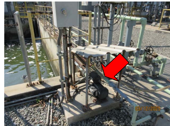
รูปที่ 25 ปัมควบคุมน้ำทิ้งกลับมาใช้ใหม่
